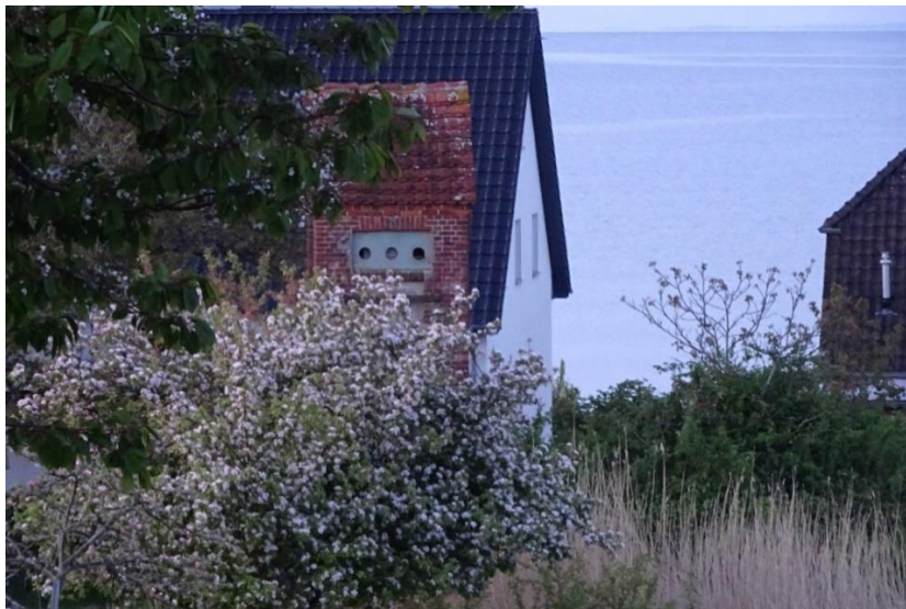
Abb. 3: Trafohaus am Rande des Plangebietes (PLANUNGSBÜRO SEPPELER 6/2023)
